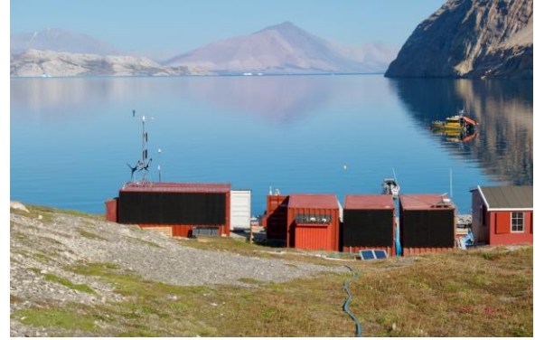
Nyt solcelleanlæg på Ella Ø erstatter benzin generator - nu kan man endelige nyde stilheden og udsigten. Foto Søren
