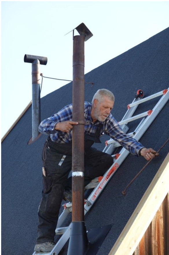
Montering af skorstensinddækning, der sikrer at der ikke kan sive smeltevand ind ved skorstenene.
