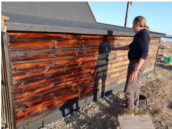
Maling med trætjære – på tilbygningen ...
