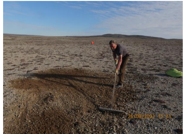
Udjævning af den nye landingsbane. Den ligger på et fladt plateau blot 175 meter fra huset.
