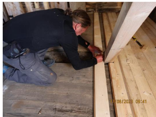
Nye gulvbrædder lægges ovenpå det gamle gulv i det store rum.
