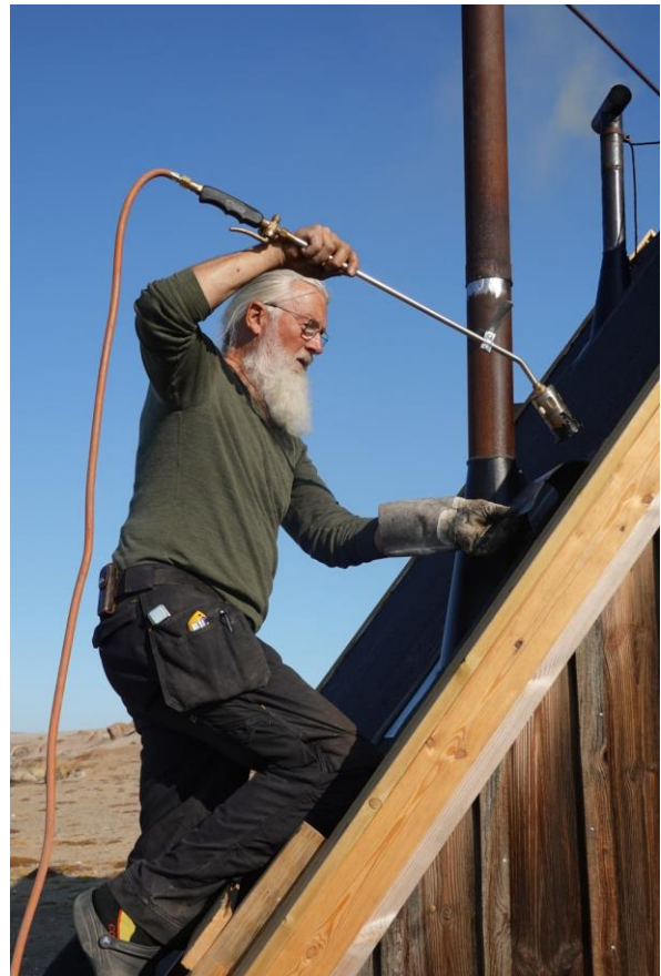
Montering af skorstensinddækning, der sikrer at der ikke kan sive smeltevand ind ved skorstenene.
