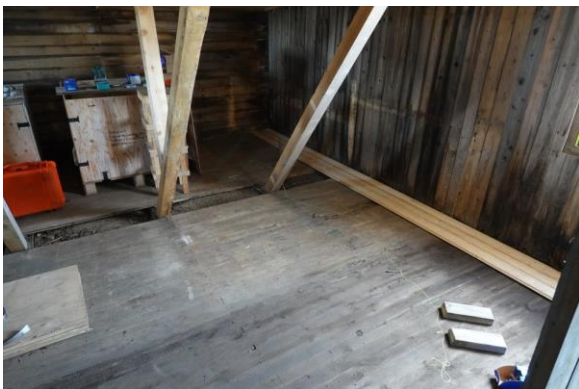
Nye gulvbrædder lægges ovenpå det gamle gulv i det store rum.
