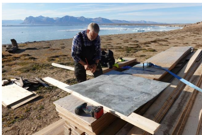
Udskæring af zinkplade til brandbeskyttelse.
