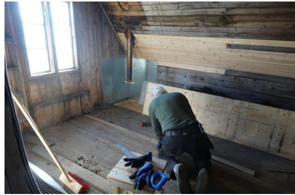
Udskiftning af gulvbrædder i det lille rum.
